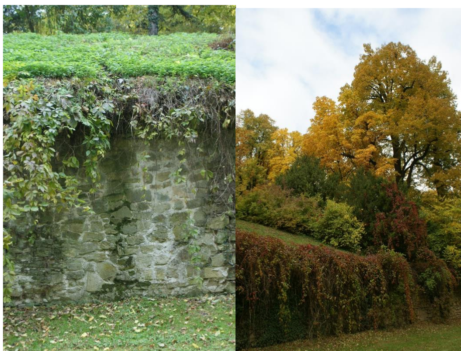
31-35. Fotografie ilustrujące najczęstsze zniszczenia murów fortyfikacji – pęknięcia i pustki, uszkodzenie gzymsu kordonowego, wypłukanie fugi, porost przez mikroflorę, całkowite wchłonięcie budowli przez niekontrolowany rozrost roślinności.
