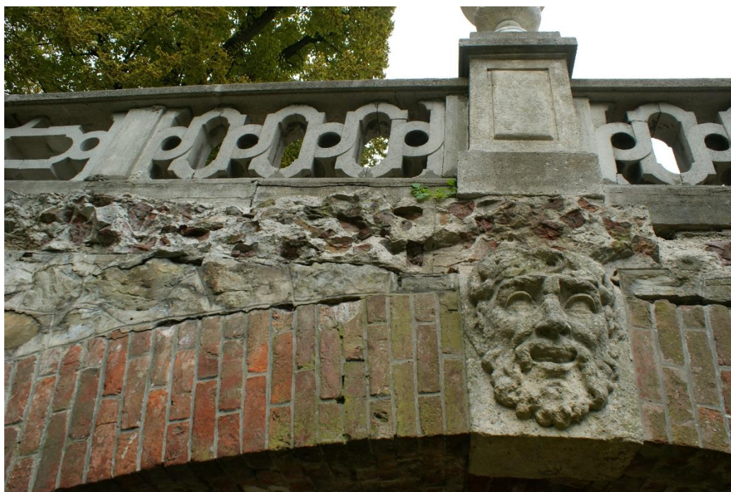
4. Most zachodni, widoczne braki gzymsu kordonowego i wizerunek maskarona w zworniku łuku
