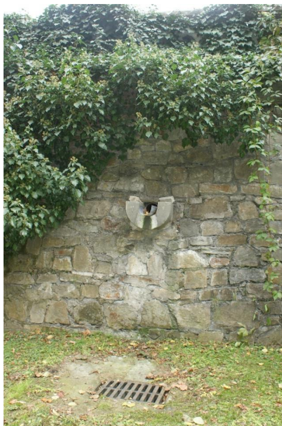
7. Odwodnienie, rynna wypustowa ściany kurtyny zachodniej
