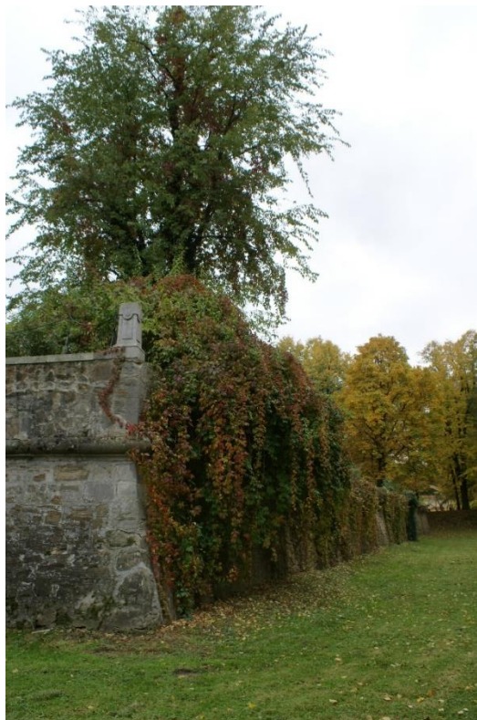
16. Narożnik zachodni barku i czoła południowo-wschodniego bastionu, widoczne znaczny rozwój flary na powierzchni murów
