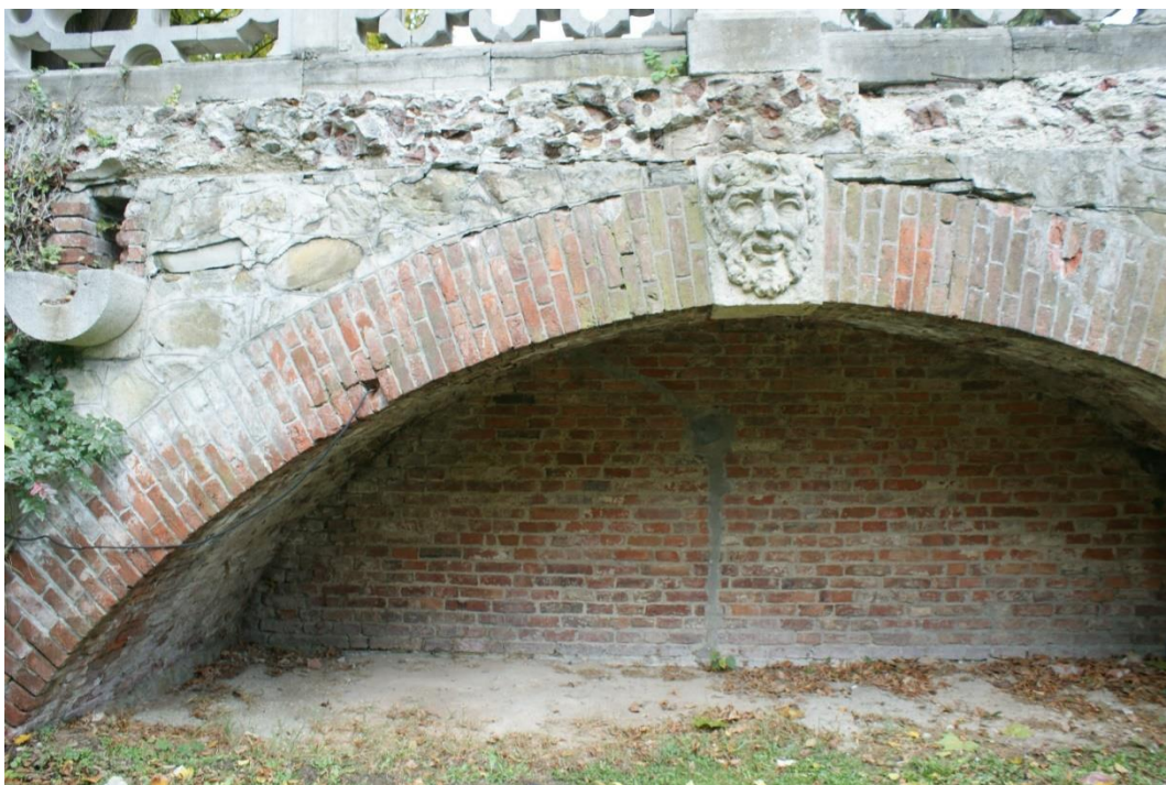
5. Most zachodni, widoczne braki gzymsu kordonowego, po lewej stronie widoczny wypust odwodnienia.
