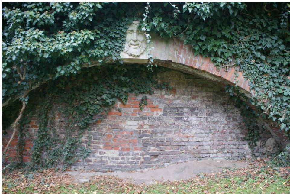
30. Zamurowanie prześwitu mostu zachodniego.
