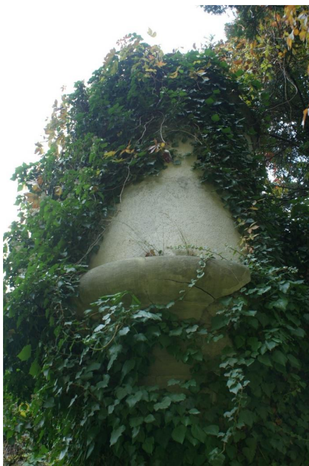
9. Kawaliera zachodniej kurtyny, mocna destrukcja tynków, znaczne zniszczenia przez roślinność
