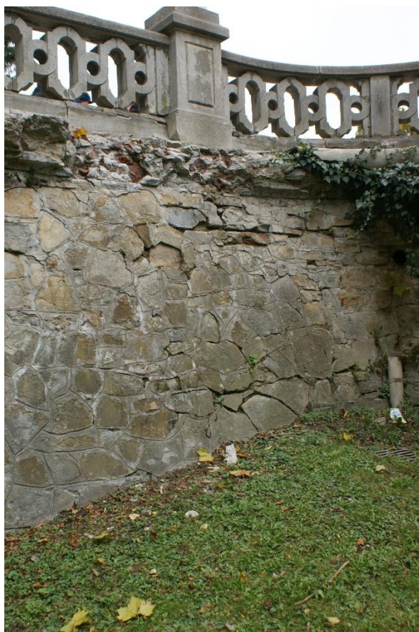
3. Most zachodni dolna część, widoczna balustrada i kamienna okładzina grobli
