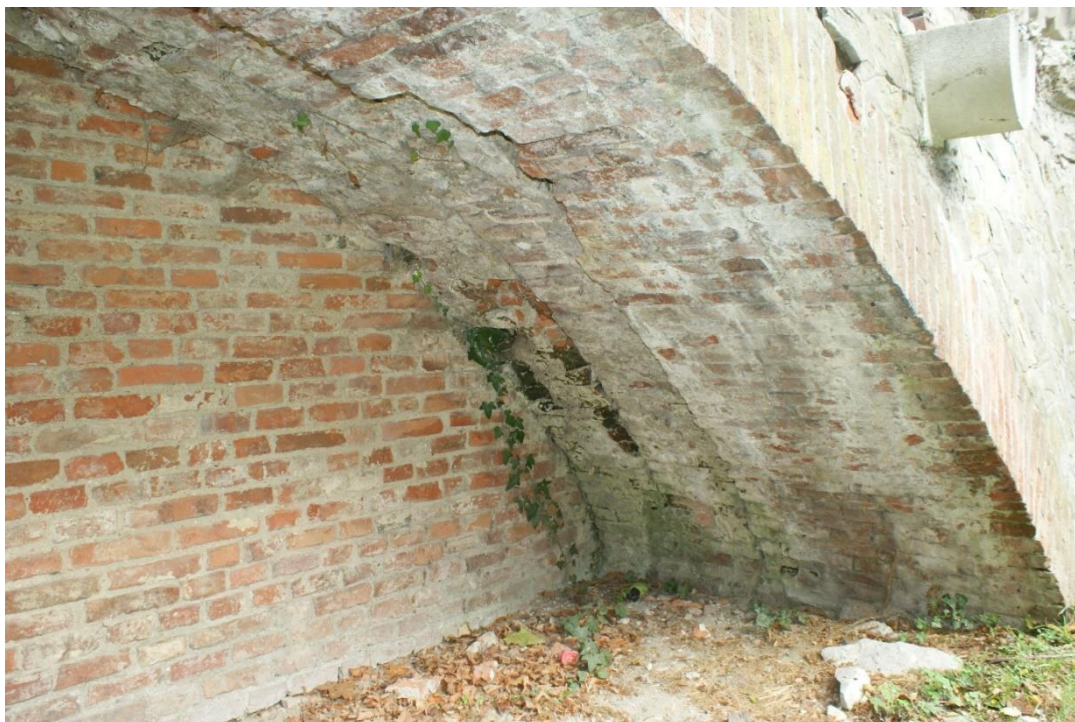
6. Most zachodni, podłucze mostu i ceglana zamurówka prześwitu.
