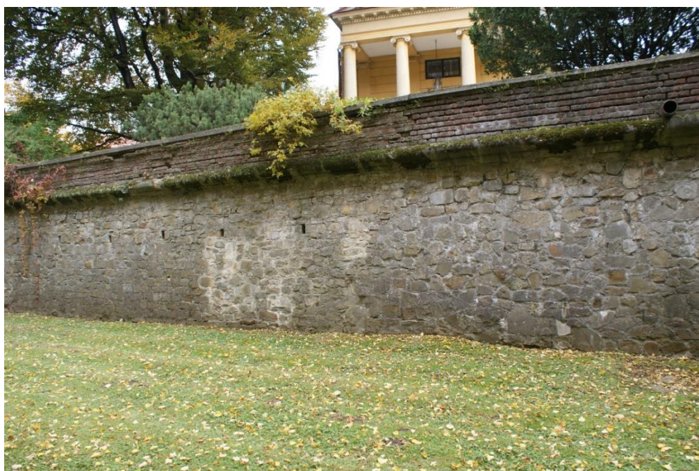
10. Bastion zachodnio-południowy, zachodnie czoło, dość dobry stan zachowania
