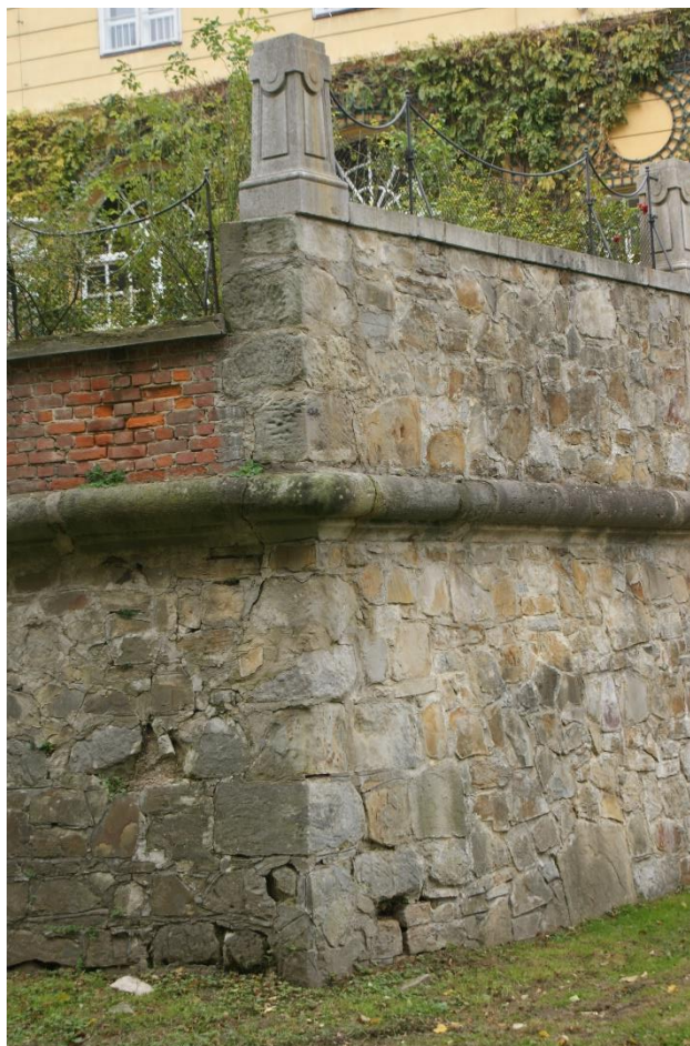
13. Wschodni narożnik czoła i barku zachodnio-południowego bastionu, widoczne połączenie ceglanego przedpiersia z kamiennym murkiem – przebudowana część fortyfikacji
