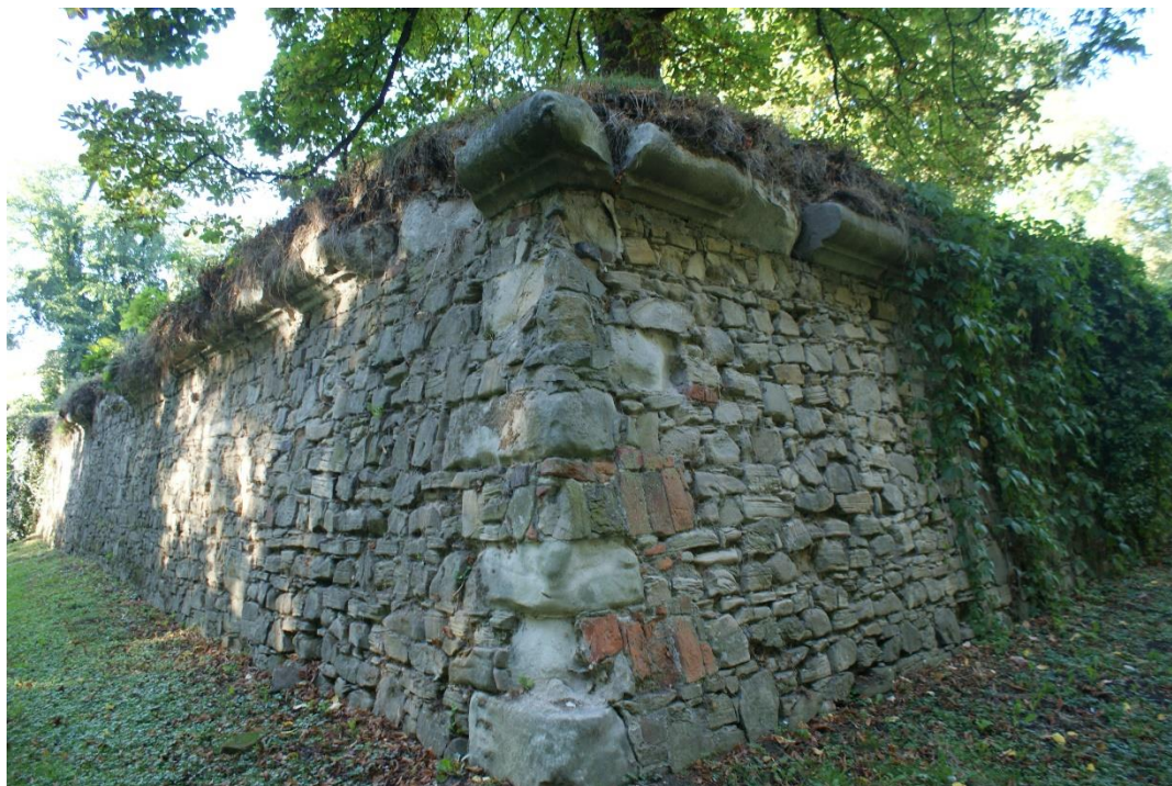
22. Bastion wschodni zbieg czół, widoczna wypłukana fuga i destabilizacja muru
